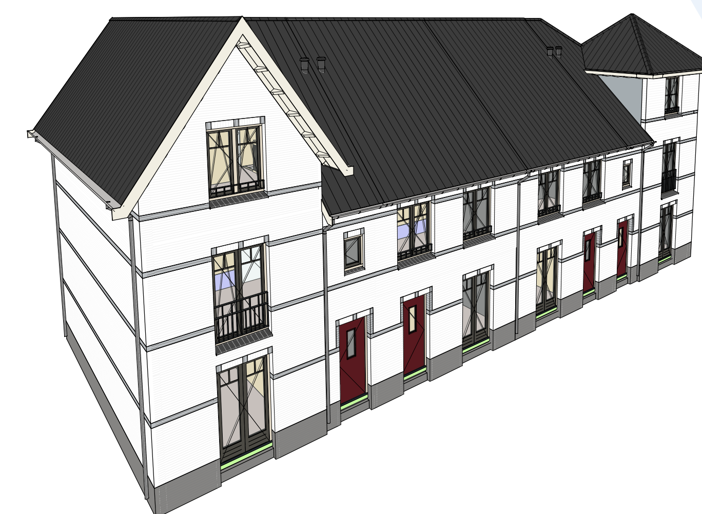
Blok 10, type D gevels bwnr. 23 t/m 26
